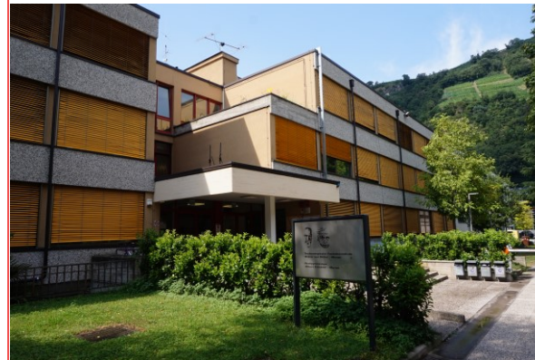
Realgymnasium und Technologische Fachoberschule Meran
